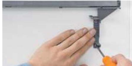
2. Trägerprofil-Aufnahmen positionieren und anschrauben
